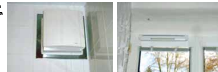
Princip delovanja higrosenzibilnega prezračevanja in videz elementov
